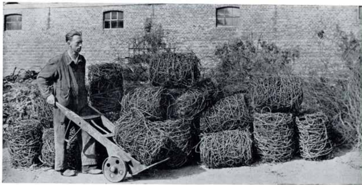
Van oud betonijzer
